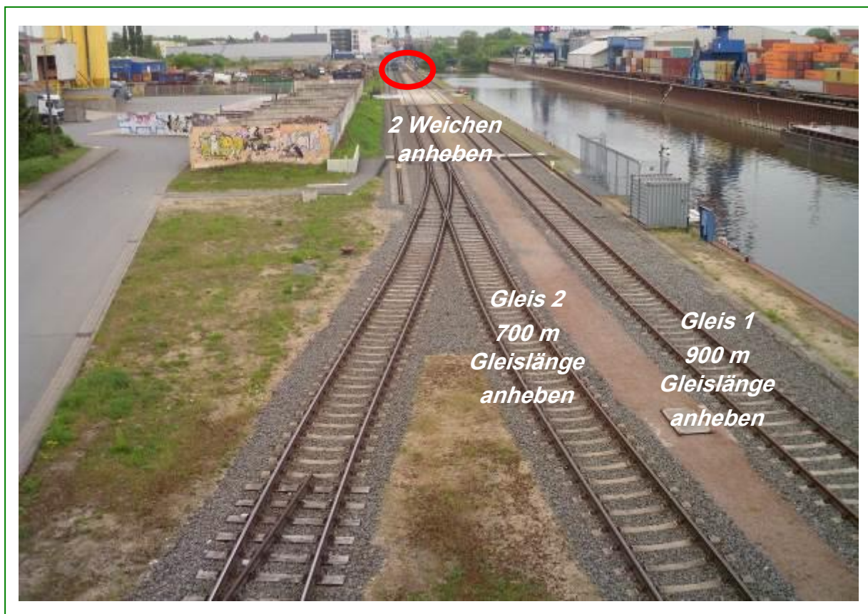
Bild 26: Ansicht Gleis- und Weichenanhebungen für Gleise 1 u. 2 (vgl. Übersichtslegeplan)
