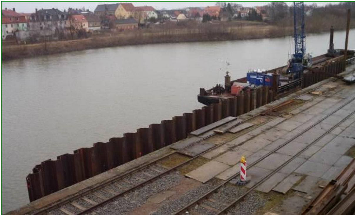
Bild 8: Angedeuteter Höhenunterschied zwischen Neubau Kaimauer u. Bestand ( \approx 0,8 m)
